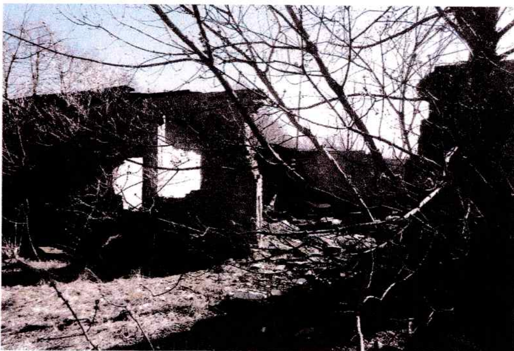
Fot. 7. Zniszczona część budynków w wschodniej części działki.
