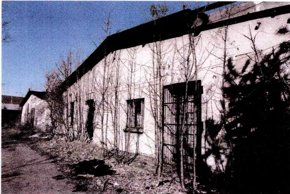
Fot. 4. Widok na południowe elewacje zachowanych budynków w centralnej części działki.
